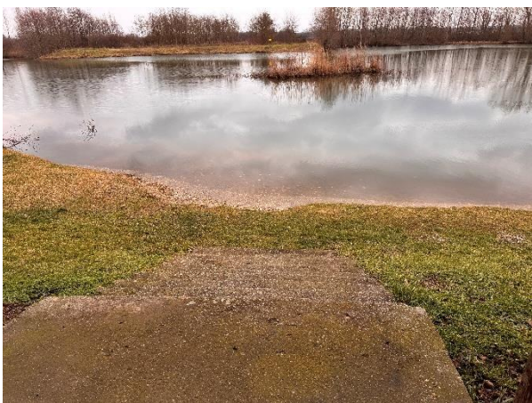
Postojeće betonirane stepenice
