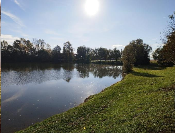
Erodirana obala na lokaciji zahvata
