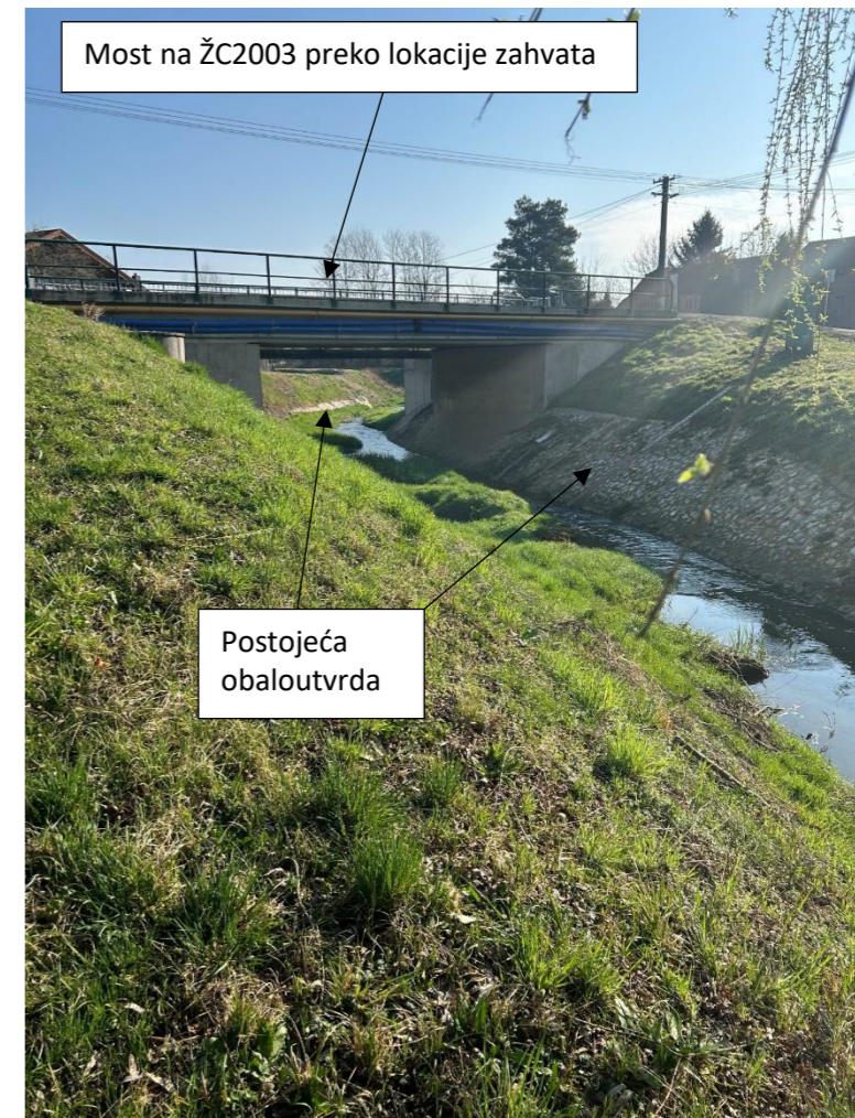
Obaloutvrda u području mosta na Martinskoj ulici
