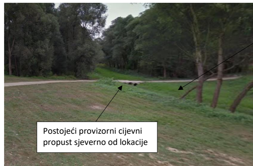
Pogled iz Murske ulice prema postojećem cijevnom propustu
