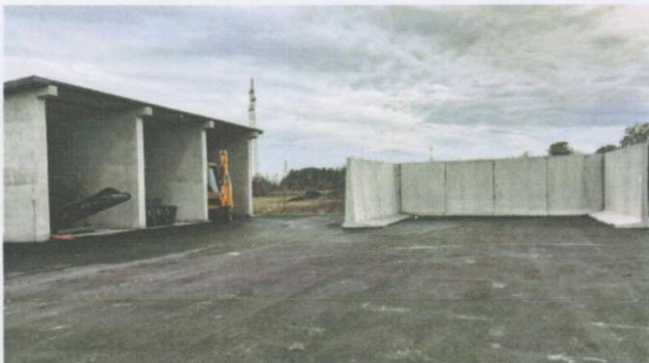
Slika 5: Reciklažno dvorište za građevinski otpad u Prelogu
