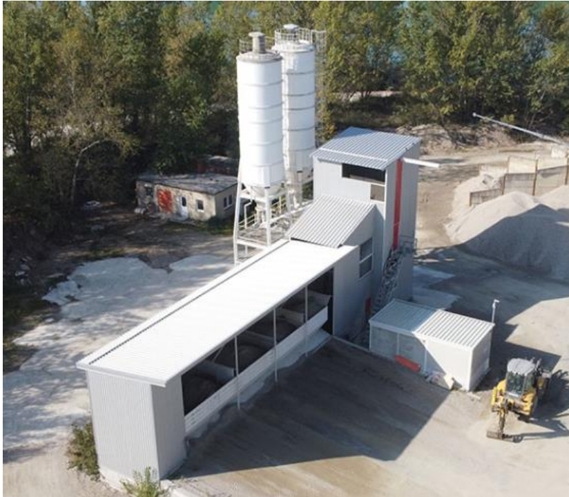
Slika 1. Postrojenje za proizvodnju betona na k.č.br. 2084/1, k.o. Ivanovec; Izvor: https://m-pmp.hr/betonare/
