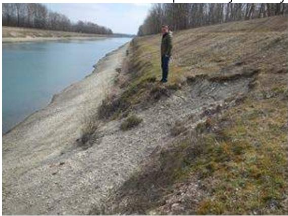
Slika 1.1.2.4. Tip oštećenja 2 - školjkasti lomovi
