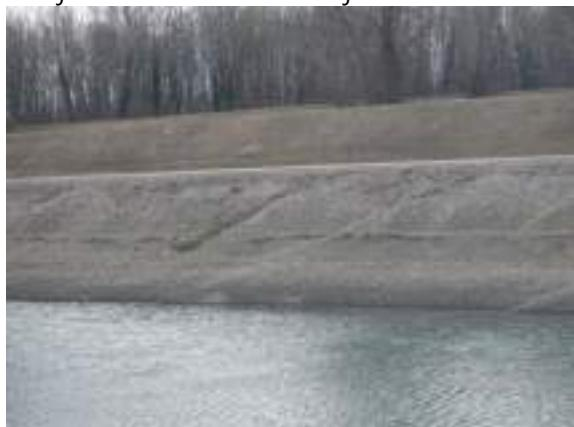
Slika 1.1.2.5. Tip oštećenja 3 - kose brazde po pokosima odvodnog kanala.
