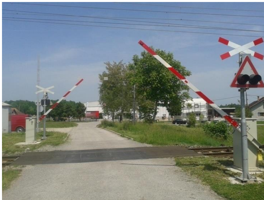
Opremljenost željezničko-cestovnog prijelaza zvučnom i svjetlosnom signalizacijom te polubranicama (izvor: HŽI)
