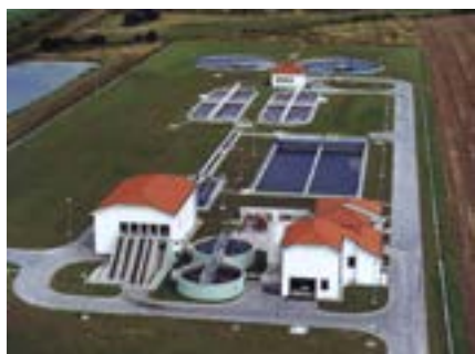
Slika 28.: Pročištač otpadnih voda kanalizacijskog sustava "Čakovec"
