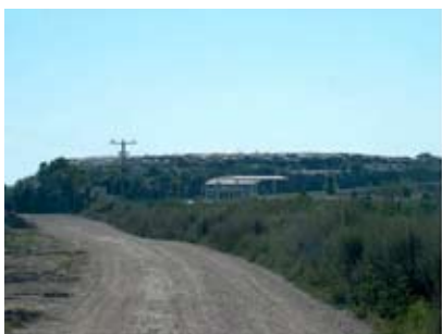
Pristupni put do odlagališta
